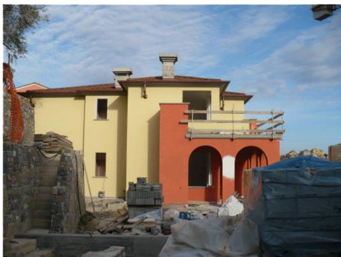
Tinteggiatura facciate con creazione di cornici e sfondatini
