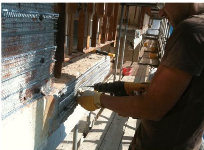
Posizionamento rete porta intonaco
