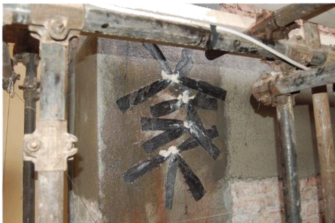
Rafforzamento strutturale tramite posizionamento di fibre di carbonio
