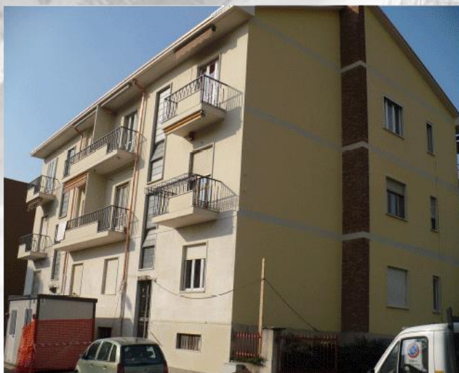
Facciata esterna e frontespizio finiti (tranne basamento) Lavorazione effettuata tutta tramite intonachino OIKOS
