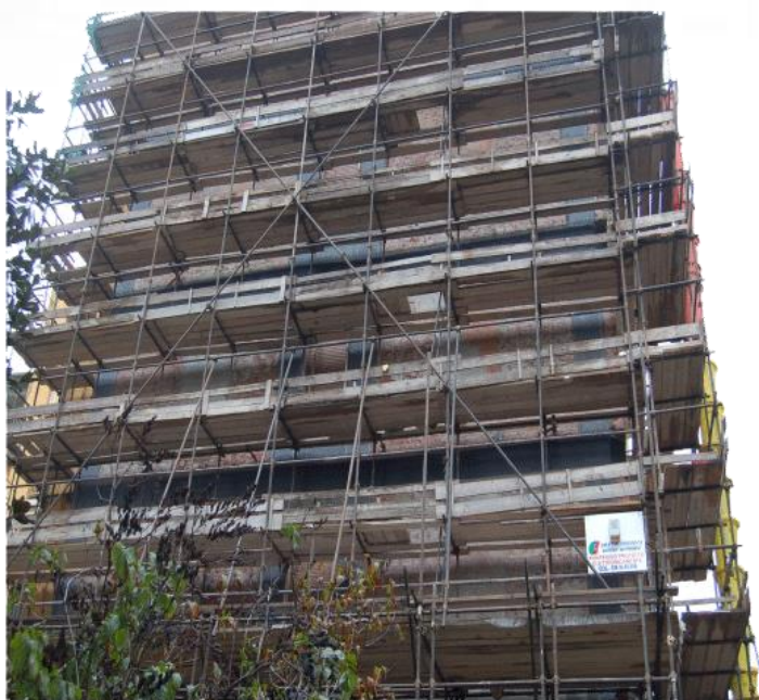
Rafforzamento strutturale tramite posizionamento di fibre di carbonio( le fasce nere evidenziano il perimetro del rafforzamento)
